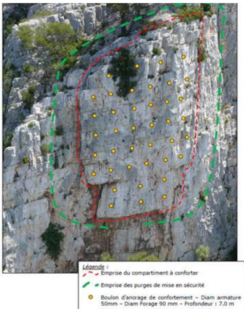
Les têtes d'ancrages seront engravées de façon à ne pas interférer avec les voies d'escalade.
